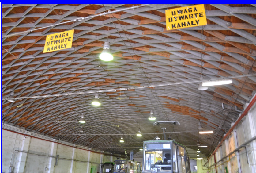
Wnętrze hali remontowo garażowej przy ul Browarnej, i jej konstrukcja spodniej części dachu
